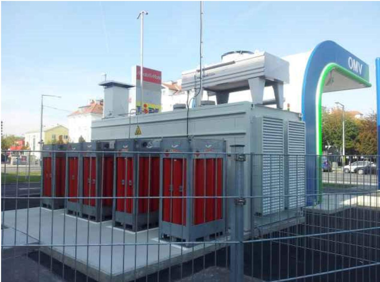
Abbildung 45: Rückseite Wasserstofftankstelle (Flaschenbündel) (Roman Sykora, ÖBFV)
